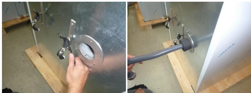
Abbildung 56: Befestigung der Klemme und Durchführen von dem Rohr.
