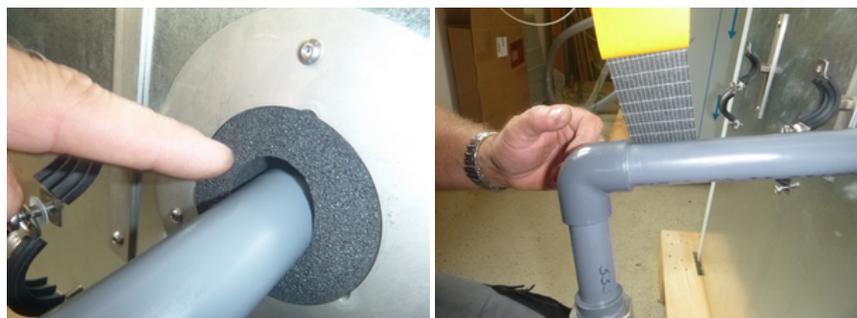
Abbildung 57: Isolierung der Wasserleitung.
