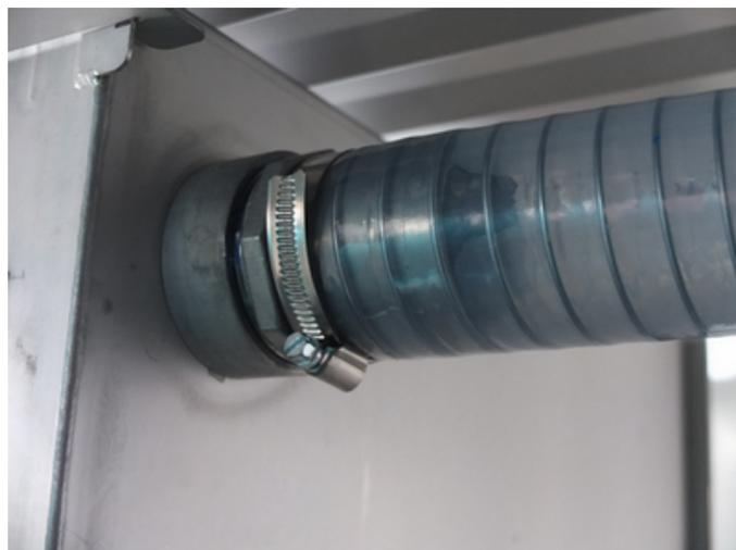
Abbildung 15: Verbindung des Ablaufschlauches mit dem Innenbehälter
