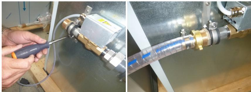
Abbildung 60: Befestigen von dem Motorventil und die Verbindung mit dem Wasserleitung zum Außenbehälter.
